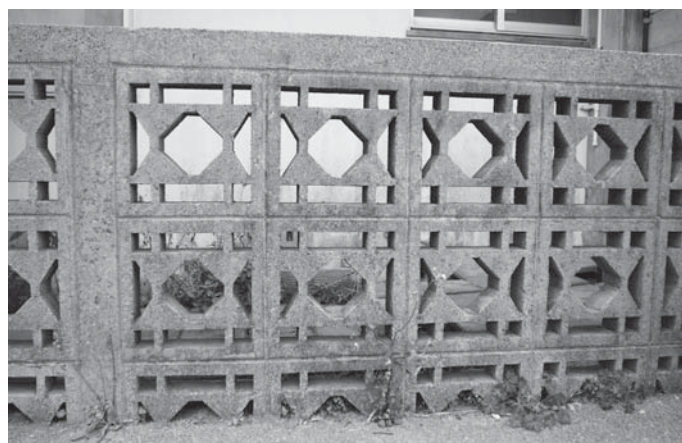
fig.13 貝殻の混入している花ブロック(山内コンクリートブロックの塀より)
