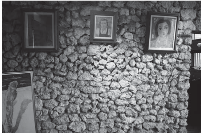
fig.24 室内の石積み壁面
