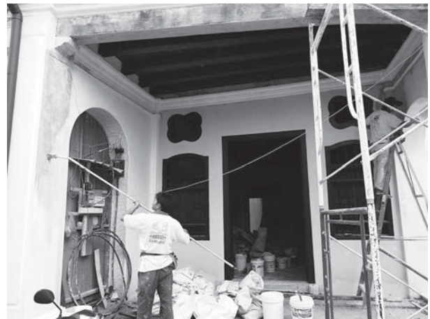
写真 17 外国人労働者により改修中のショップハウス (2014年8月25日筆者撮影)
