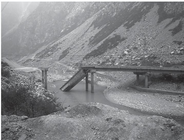
写真2 今でも残る崩壊した橋梁—汶川県内にて (2012年3月筆者撮影)
