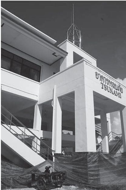
写真4 ビーチリゾートに建設された 津波避難タワー（ピビ島） (2012年5月1日筆者撮影)
