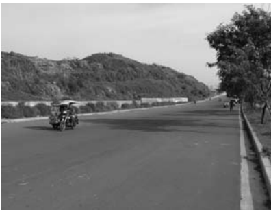
写真2 整備後の旧スモーキーマウンテン（2009年） この街路は、写真1の街路に隣接して新たに整備された。（筆者撮影）
