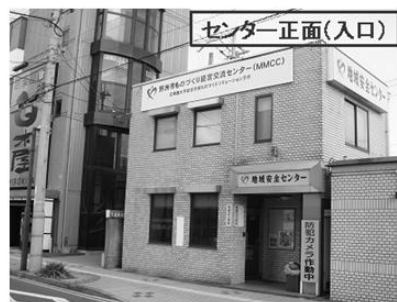
注) MMCC からの提供
