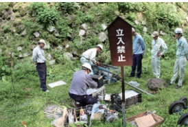
▲ 東北太平洋沖地震による仙台城石垣被災状況調査
