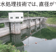
▲ 惣の関ダム(宮城県)でのフィールド実験
