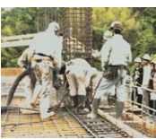
▲ コンクリート打設見学風景
