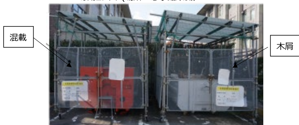
専用コンテナ(場所：志学館東側)
