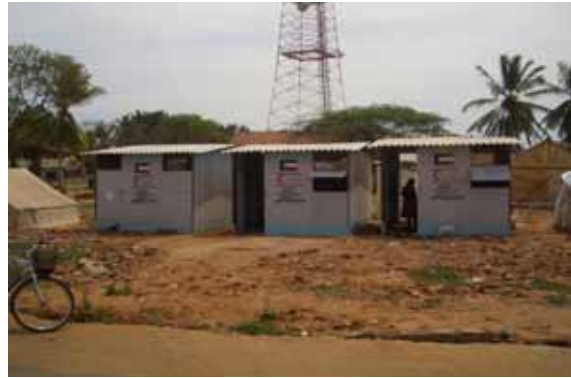
津波仮説住宅 05 5.11
