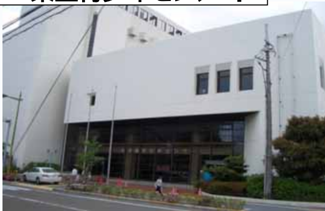
改修前の 「県立青少年センター」
