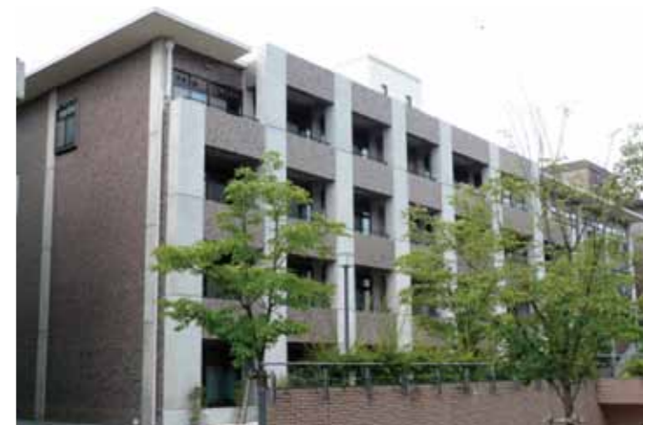
▲耐震工事を終えて、新しい外壁ができた啓明館(心理学研究室のある建物)
