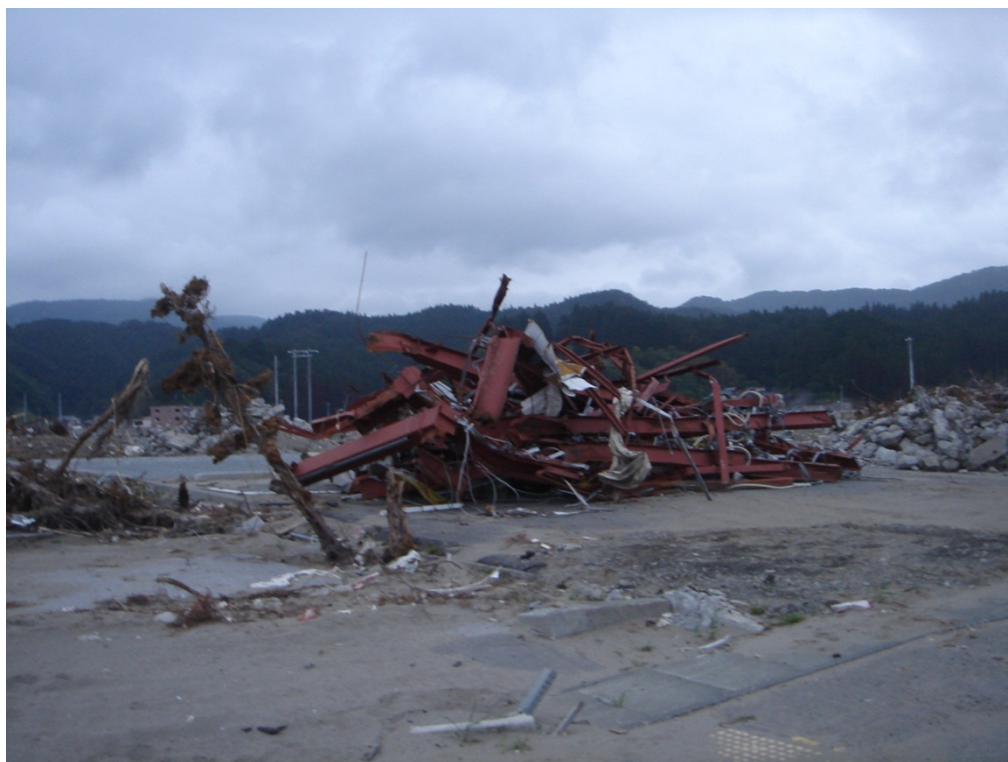
陸前高田⑤ 津波被害にあった建屋
