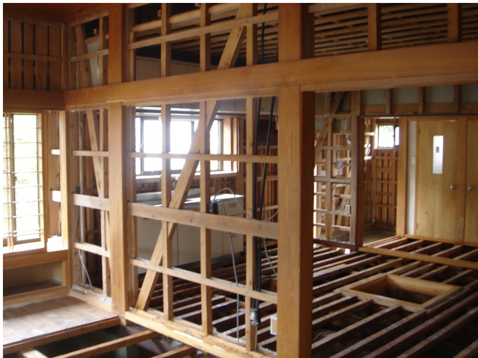
大船渡⑦ ボランティアで天井と壁を撤去した邸宅
