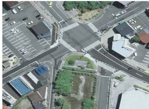
図-1 施工前の信号交差点
