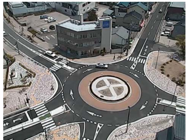
図-11 CATVによって撮影されたラウンドアバウト環道及び流入口
