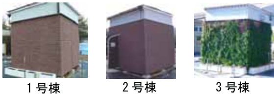
図1 屋外暴露試験棟
