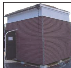
図4 屋外暴露試験棟
