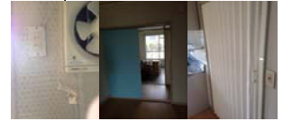
図 6 冬期改修風景
