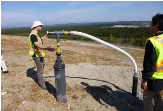
Picture 2 メタンガスを抜くパイプ
