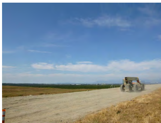
Picture 3 ごみの山の上から
