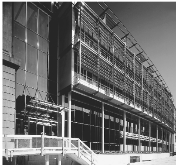
アニドリック天井システムの開口部が導入された外壁 Facade with anidolic ceilings apertures. LESO, Lausanne (IEA, 2000)
