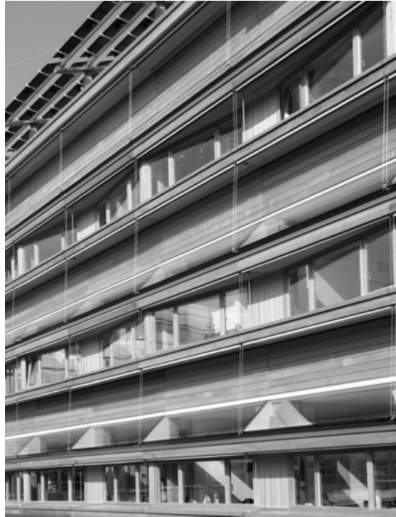
アニドリック天井システムの開口部が導入された外壁 Facade with anidolic ceilings apertures. LESO, Lausanne (IEA, 2000)
