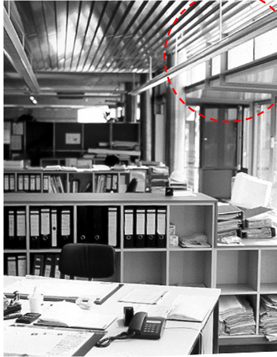
太陽光の方向を変えるガラスの取り付けられた室内。 Interior of a room equipped with sun-directing glass. (IEA, 2000, Daylight in Buildings)
