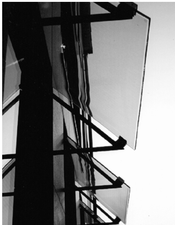
外壁に取り付けられた HOE HOE attached to facade (IEA, 2000, Daylight in Buildings)
