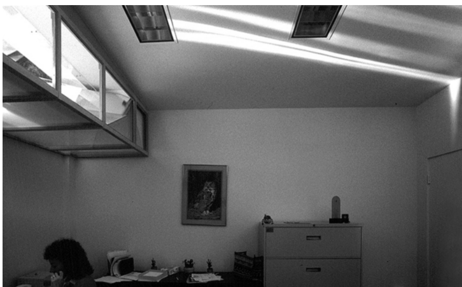
光学機器のある光の棚を取り付けたオフィス室内 Light-shelf equipped with optical element (IEA, 2000, Daylight in Buildings)
