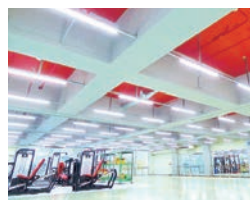
BKCジムトレーニングルーム
