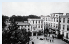
広小路学舎 写真提供：立命館 史資料センター
