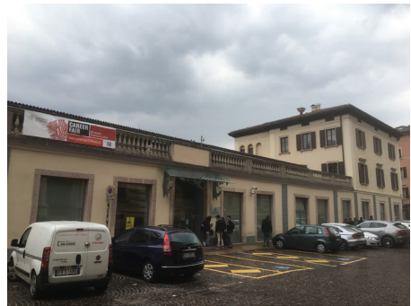
トレント大学法学部
