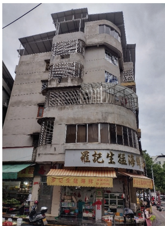
図13 梅州市内の八百屋。窓やバルコニーには隙間なく鉄格子が嵌っており、衛生環境以外に、治安もなお、不安定である面があることを思わせる。
