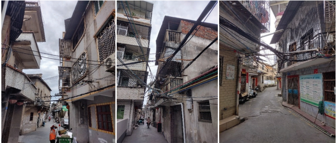
図 10 いずれも住宅街の風景。電線の敷設、建増等が無造作に為されている感がある。
