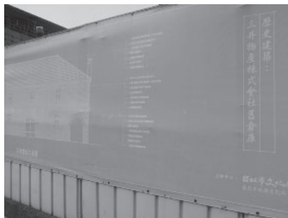
写真2 旧三井物産倉庫の修復現場
