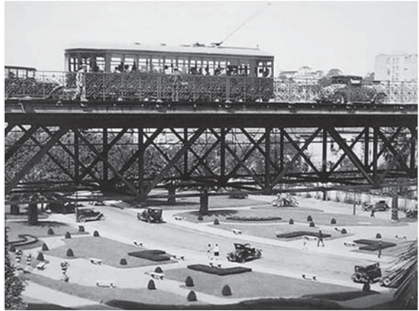
図2 チャー高架橋。アニャンガパウー溪谷にフランス人ジュール・マルタンによって設計・建設された、サンパウロ最初の陸橋。下がアニャンガパウー公園。
