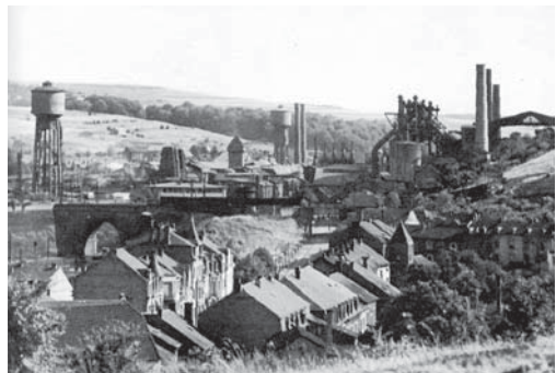
Fig.6 Two water towers seen from the Italian quarter, in Kaell Architecte and Jim Clemes Atlier d'Architecture et de Design ed., De Wassertuerm zu Diddeléng , Centre nationale de l'audiovisuel, 2012, p.23.
