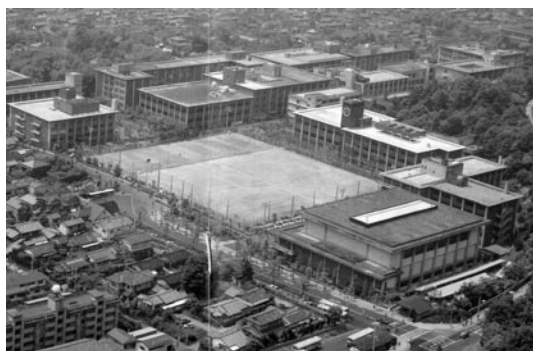
【写真6】一拠点完成時の中央グラウンドと周囲の校舎
