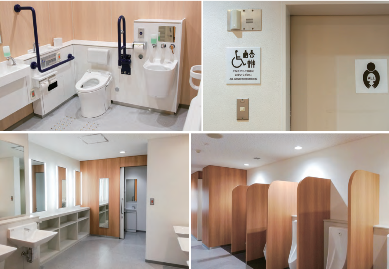
左上・右上：E棟1階多目的トイレ、左下・右下：F105教室横トイレ
