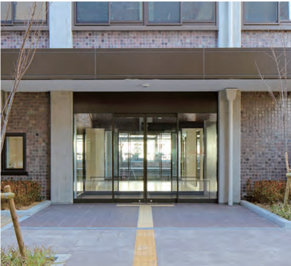
エントランス部の段差解消と自動ドア化(啓明館)
