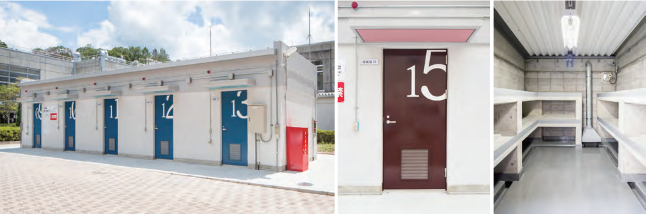
室番号を大きく表示した扉のデザイン
