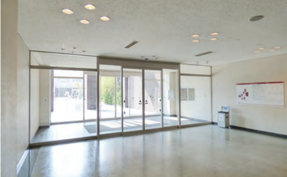
エントランス自動ドア改修(アクロスウイング)
