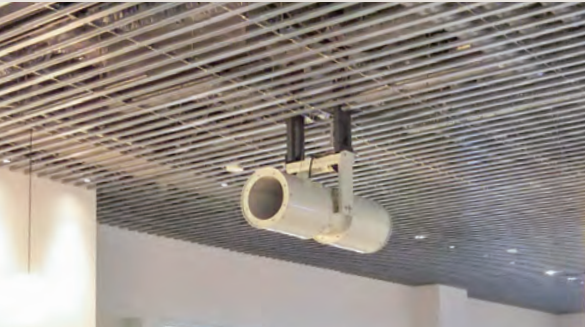
コンコースに換気設備を設置(大阪いばらきキャンパス)
