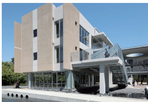
BKC トリシア：理工系新棟Ⅱ (供用開始：2014年5月)
