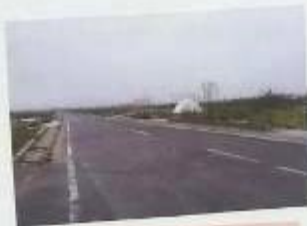
2012.8.10 宮城県仙台市若林区 荒浜地区 住居地の2000坪ほど、土崩れし全 壊された。
