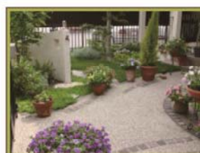
リズムカルなピンコロの並びと コンクリートの洗い出しのアプ ローチ
