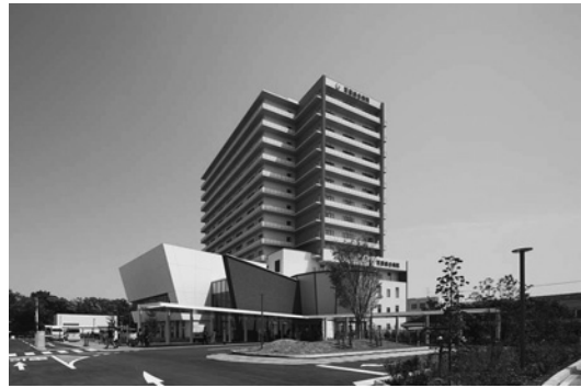
図8 完成後の病院の全景 高層棟は病棟、低層部分は地域交流ゾーン (写真提供：社会医療法人同仁会)
