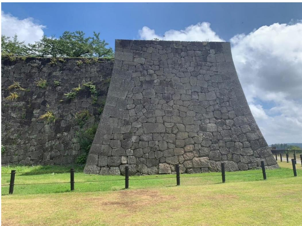
小峰城の石垣。草や苔の生えていない部分は地震で崩れた。地震によって石垣が崩壊し、人が怪我をしないように柵が出来ている。
