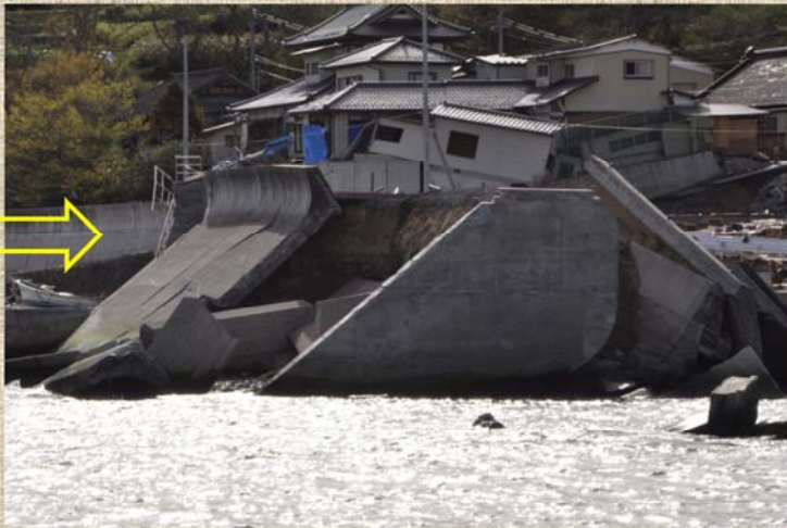
破壊された堤防の様子。堤防は襲ってきた津波ではなく引き波で破壊されたことがわかる。この堤防は陸側が急角度で地面から7mほどまで立ち上がっており、引き波をまともに受けて破壊されたと推定される。
