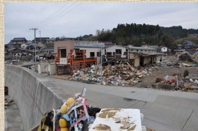
津波は港と市街地の間にある高い堤防を乗り越えて市街地を破壊。下の2つの写真は堤防の前の市街地の被害状況を示す。右下の写真の右奥にある慈恩寺はこの地区の避難所として活用された。ただ津波はお寺の庭にまで達し、避難者の車は使用不能となった。
