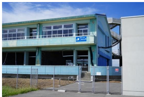
震災遺構 請戸小学校
