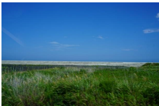
長ーい防潮堤
