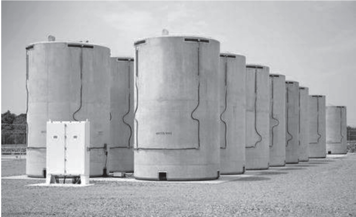
図2 アメリカのマクガイア原発の使用済み核燃料貯蔵エリア。 一つ一つが使用済み燃料を格納したキャスク
