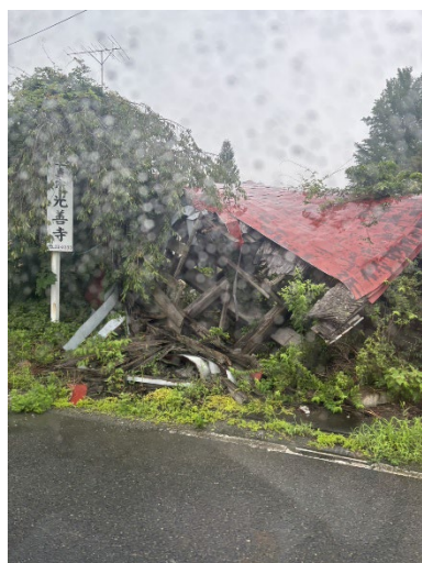
写真3 崩壊したままの住宅
