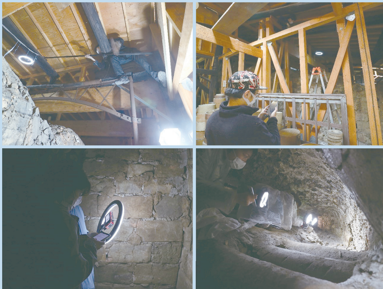
京都市東山区・五条坂京焼登り窯（旧藤平）の3D写真測量の様子（2021年10月25-29日）
