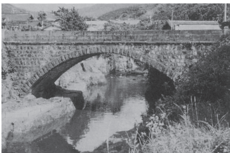
写真2 倉淵橋（世知原町）
