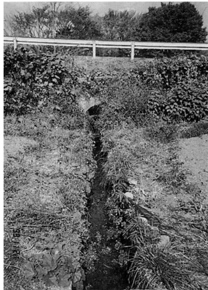
写真2 マンボ出口付近（筆者撮影） 名神高速道路の真下に出口が位置するため出口付近はコンクリートの土管が埋め込まれている。水路から両脇1 mがマンボ所有者の土地で、底浚えをおこなった後の土砂をあげておく場所として使用される。
