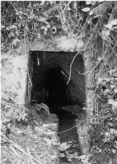
写真1 マンボ入り口付近（筆者撮影） 水路はコンクリートづくりとなっており、入り口付近もコンクリート張りとなっているが中は素堀のままである。入り口付近の高さは1 m程であるが、奥に行くほど狭くなっている。
