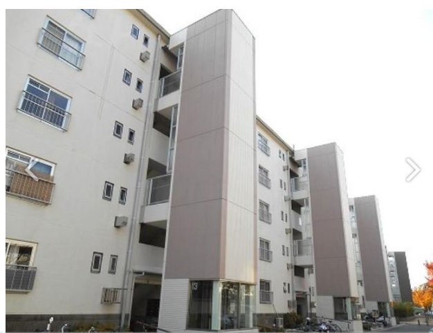
写真 エレベーター増設状況 (玉川橋団地) (出所：UR 西日本支社 HP)
