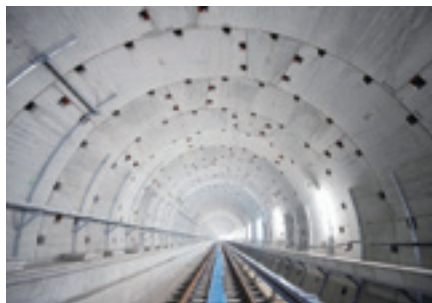
北大阪急行線延伸シールドトンネル
