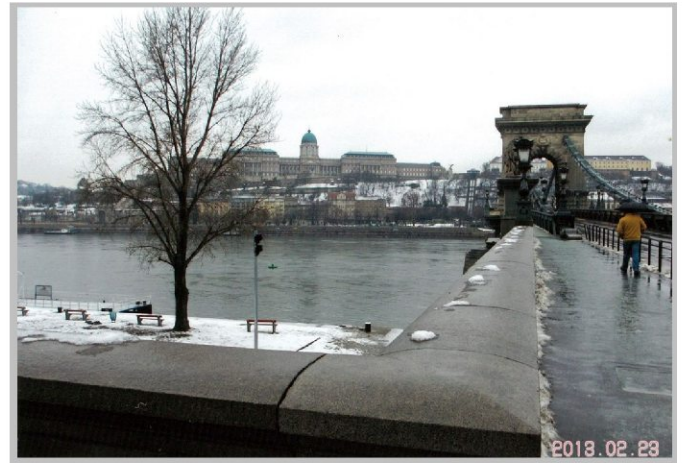
(写真②：ブタ地区からダニューブ川を挟んでペスト地区を眺望する)
