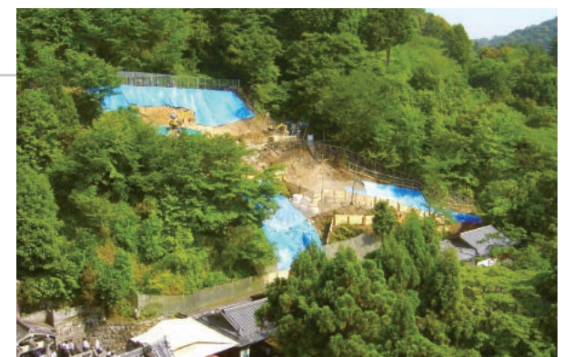
2013年清水寺音羽の滝横の斜面崩壊に対する復旧工事
