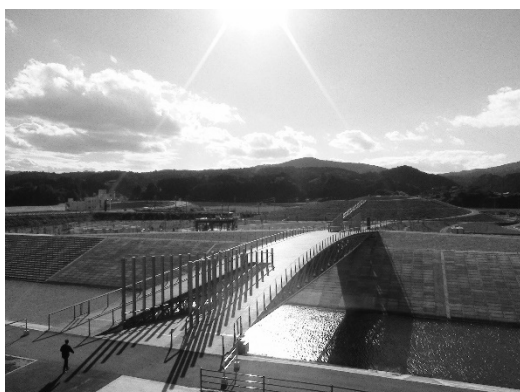
2022 年南三陸町 被災河岸整備
