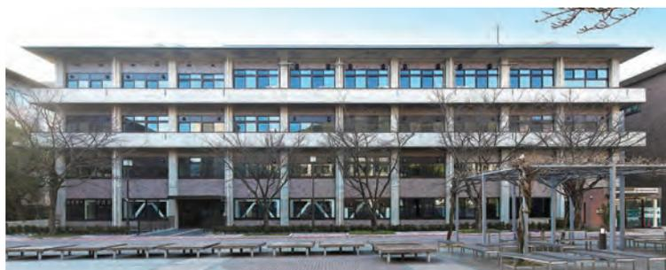
2020年度の文学部カリキュラム改革に合わせて、文学部の基本棟である「清心館」の全面的なリニューアルを行いました。より多様で、より充実した教学を展開できる空間の整備を目指し、歴史ある外観の趣は残しつつ、ゾーニングを再編し内装を一新するとともに、老朽化した各種設備を更新しています。外壁・外部建具の断熱化、照明のLED化、空調設備等の更新により、消費エネルギーは改修前と比較し、建物全体で41%削減できる見込みです。
