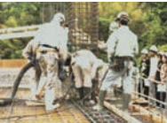
▲コンクリート打設見学風景
