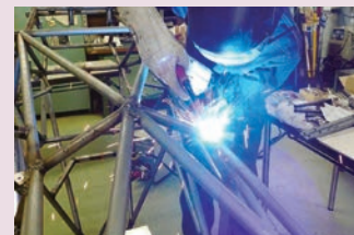
■ アーク溶接による溶接風景
