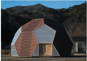
▲被災地に建設した仮設の集会所
