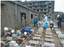
▲軍艦島に暴露した鉄筋コンクリート試験体の定期測定の様子（長崎市の特別な許可により撮影）
