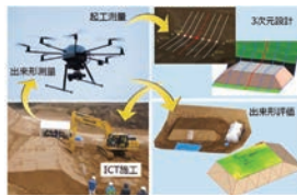
▲ICT技術を活用して情報化・自動化が進む土工施工現場。更なる高度化には、地盤情報のリアルタイムセンシングが欠かせない。
