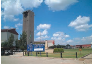
▲金生産量が南ア最大で採掘が地下3.4kmで進みつつある金鉱山の竖坑塔
