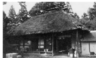
図2 栗原地方の四間取り田の地型住宅 工藤家住宅の母屋（昭和45〔1970〕年）、 栗原郡高清水町に所在。建築は江戸中期 と推定（宮城県教育委員会 [1974:40]）。
